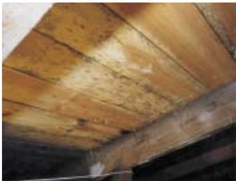
Den avfuktade vinden är numera torr och mögelfri.
